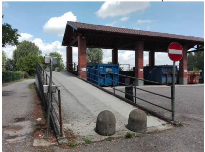
Rampa e tettoia
