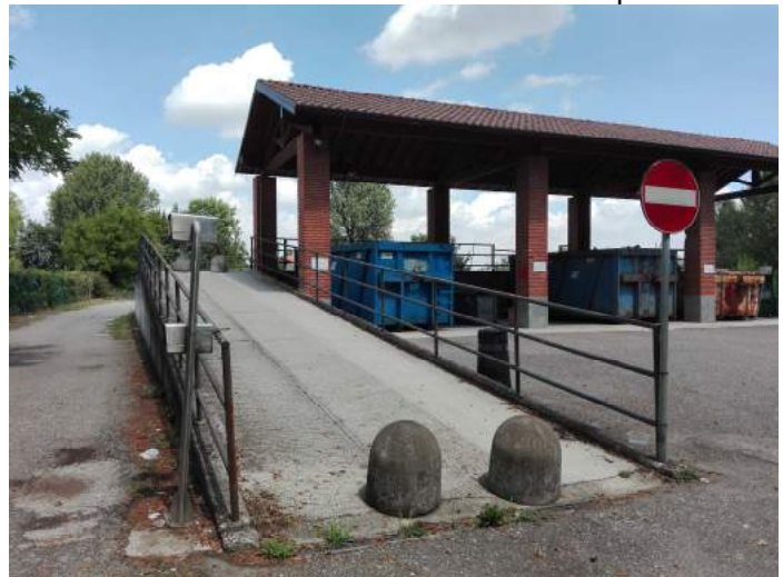
Rampa e tettoia
